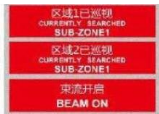
图 4.1.2.1-6 束流闸回旋加速器区域束流（工作）状态指示灯示意图 （区域 1、2 分别指束流传输隧道区、回旋加速器区）
